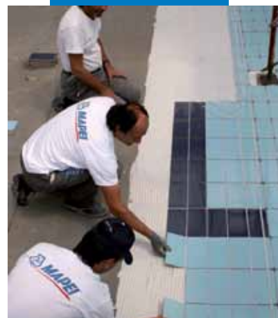
Укладка керамической плитки на Mapelastic в бассейне
